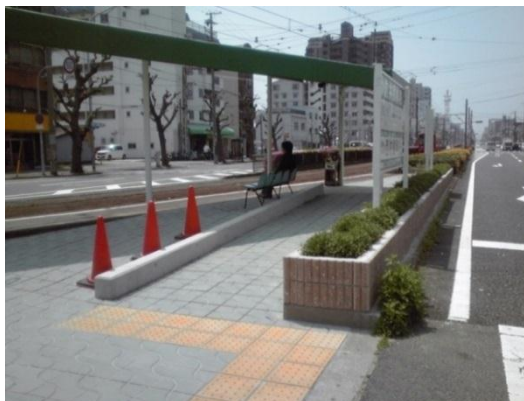
スロープの設置（阪堺線綾ノ町停留場）
