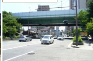
⑤砂道翁橋線との交差点付近
