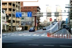
⑥北花田口跨線橋付近
