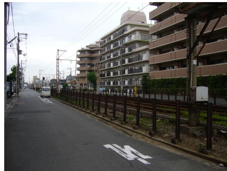
(浜寺方面停留場改修前)
