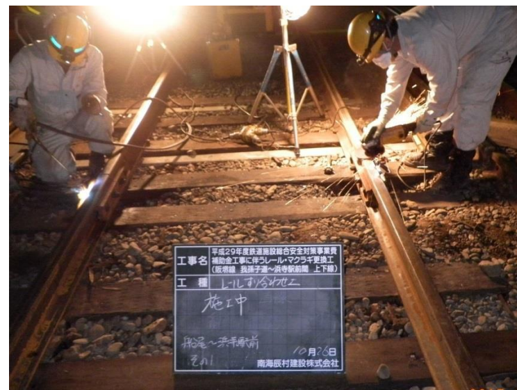
軌道改修工事状況
