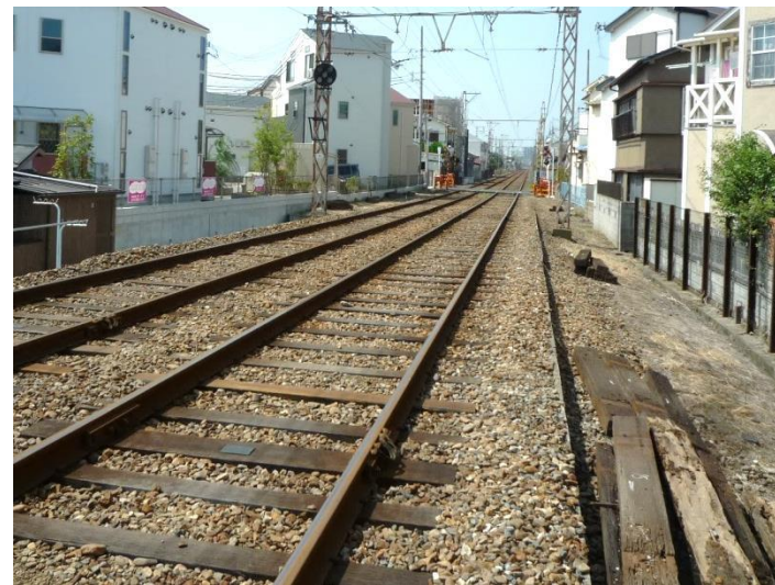
老朽化の激しいまくら木を交換
