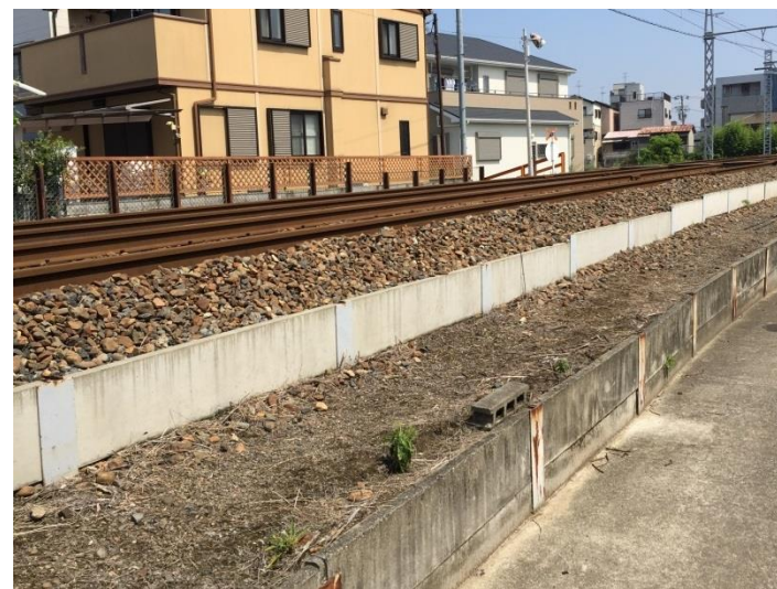
線路側面にコンクリート板を設置
