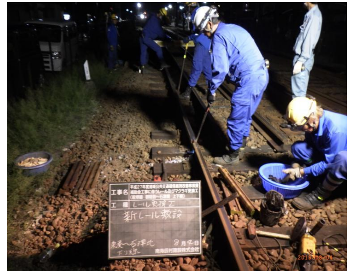
軌道改修工事状況
