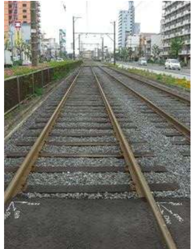
整備された軌道
