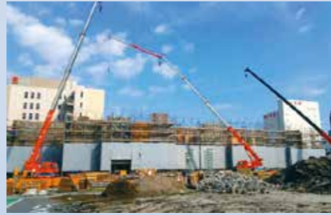
堺市文化観光拠点 「さかい利晶の杜」工事現場
