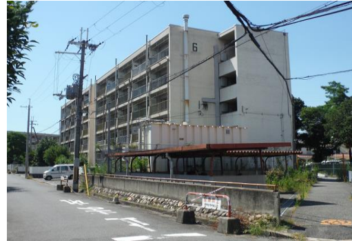
公営住宅等整備事業 万崎住宅建替事業（1期解体工事）
