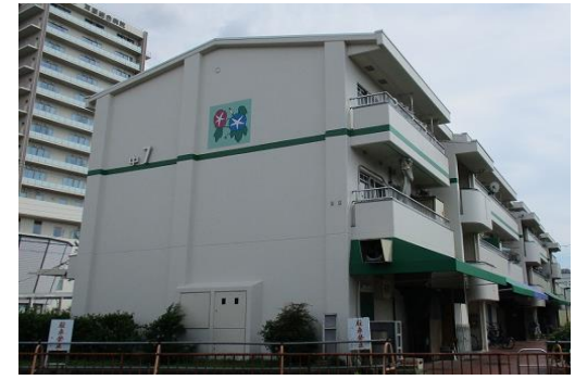
公営住宅等ストック総合改善事業 協和町中団地7号館外壁改修工事
