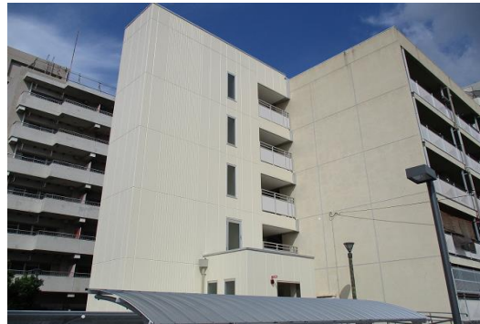
改良住宅ストック総合改善事業 協和町東団地15号館昇降機棟増築工事
