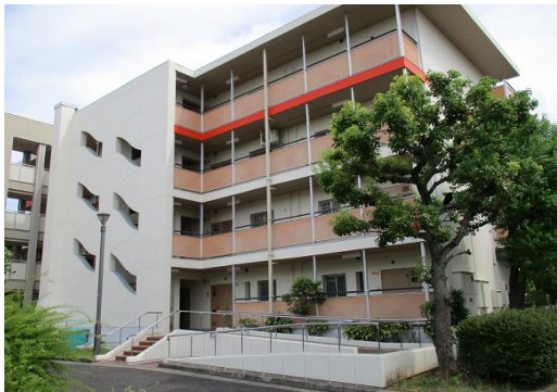
改良住宅ストック総合改善事業 協和町西団地7号館外壁改修工事
