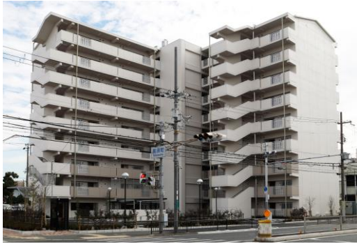
公営住宅等整備事業 北清水住宅建替事業（1棟建設工事）
