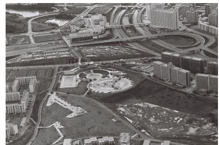
図表 1-1-5 泉ヶ丘駅付近
