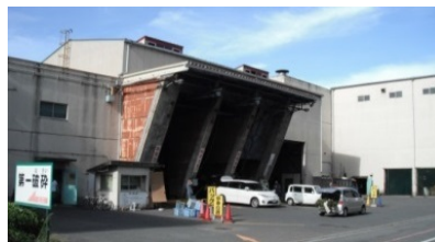
《東工場第一破碎施設》
