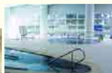
蒸気を利用した温水プール
