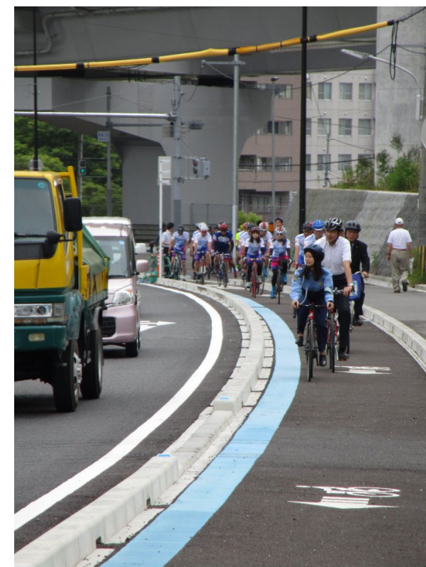
南平台日吉線（一方通行の自転車道） 平成30年5月26日開通
