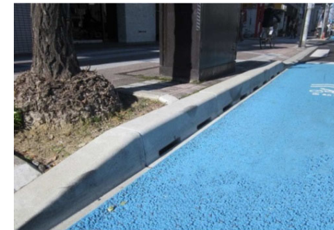
< 自転車の走行性に配慮した排水構造の例(広島県福山市) >
