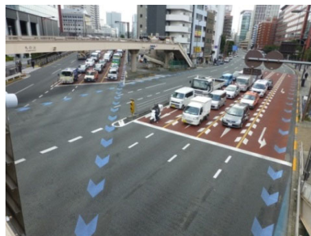
＜自転車ナビライン設置と左折車との交錯を避けた現示調整を行った例 (東京都港区・札の辻交差点)＞
