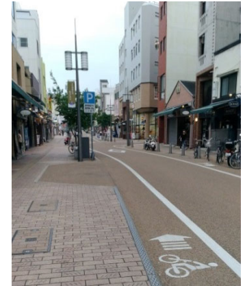
<無電柱化と合わせた通行空間の整備例(愛媛県松山市)>
