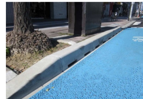
<自転車の走行性に配慮した排水構造の例(広島県福山市)> 【出典:国土交通省】
