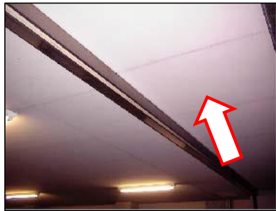
アスベスト含有ケイ酸カルシウム板（一種）（天井仕上材）
