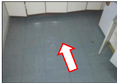
アスベスト含有ビニル床タイル（床仕上げ材）
