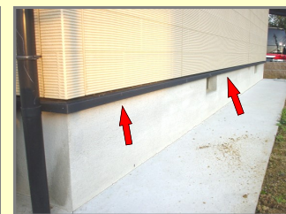
建物基礎に設置された水切り板の裏
