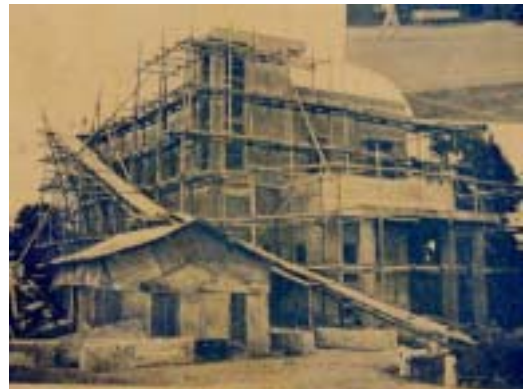
建築中の様子
