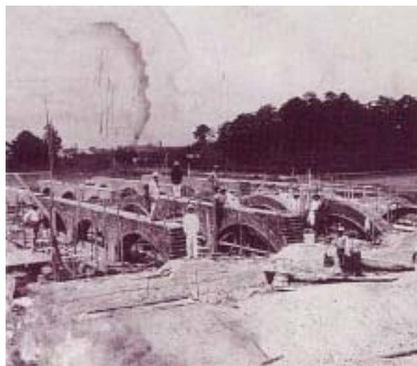
建築中の様子
