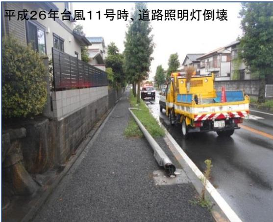
平成26年台風11号時、道路照明灯倒壊
