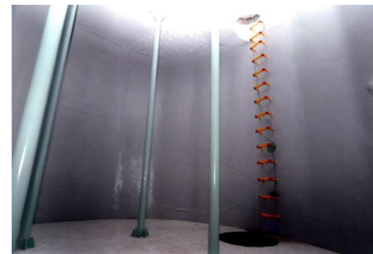
耐震補強工事後の水槽内部
