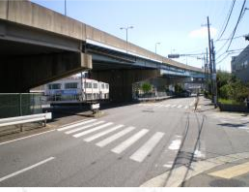
大浜高架橋 府道大阪臨海線
