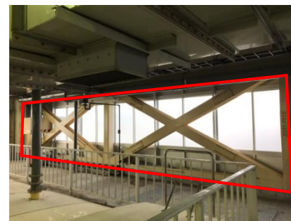
「ブレースの設置」
