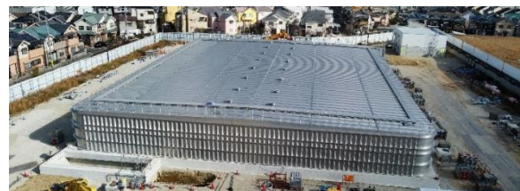
工事施工中の状況
