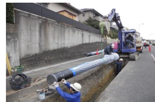
水道管（配水支管）の更新
