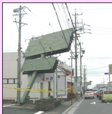
広告塔の倒壊
