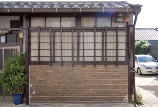
タイル貼りの腰壁
