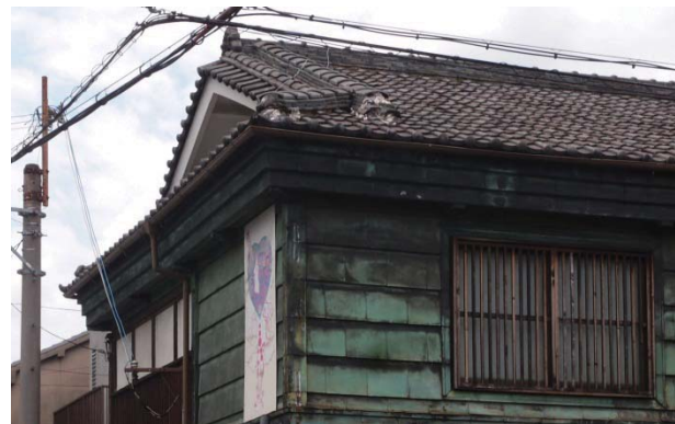
入母屋造、棧瓦葺きの屋根
