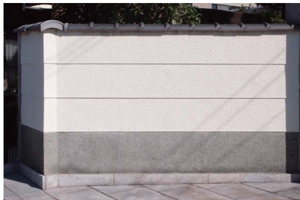
ブロック塀に築地塀風の仕上げを施した塀
