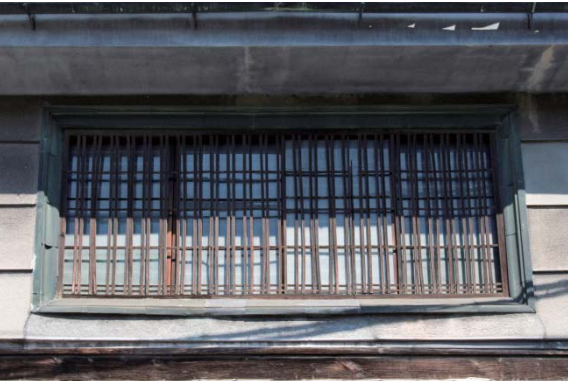
木製ガラス窓と木製縦格子
