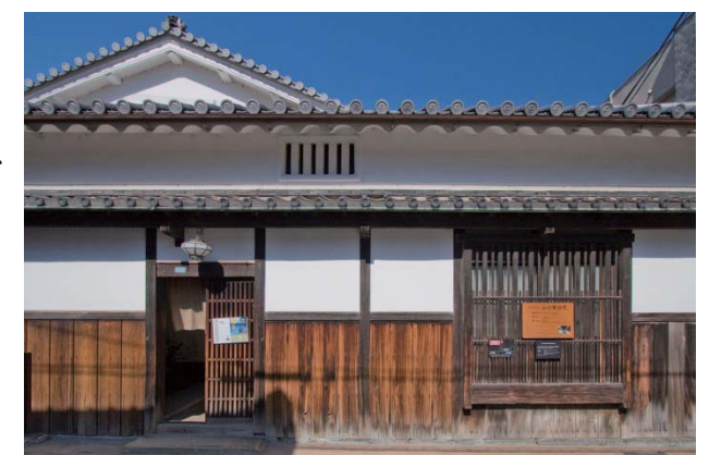
腰板と漆喰の外壁
