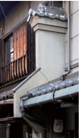
瓦がのせられた袖壁
