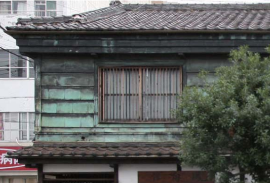
銅板張りの外壁
