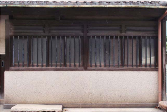
腰壁上の木製ガラス窓と金属製丸格子
