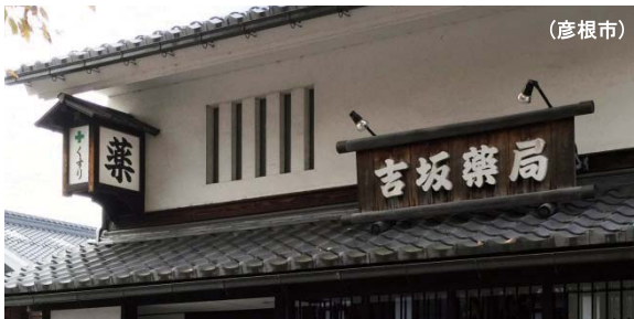
景観に配慮した看板
