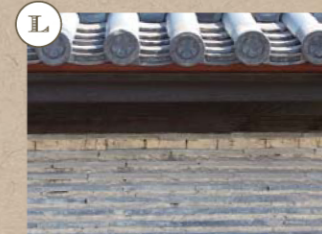
外壁は、粘土と瓦を交互に積み上げた練塚（ねりべい）。
