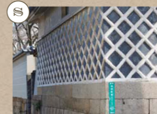
平瓦と漆喰で構成された「なまこ壁」。耐火性能は抜群。
