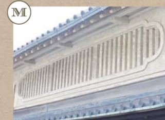
塀には四角形の虫籠窓が多いなか、曲線を用いた大きな虫籠窓が一際目を惹く。
