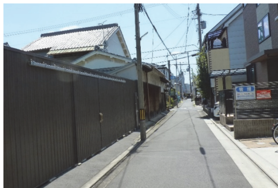
隣接する町家と腰壁の高さ、色調をあわせた塀
