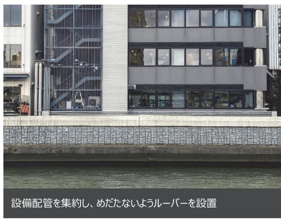
設備配管を集約し、めだたないようルーバーを設置
