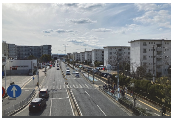
壁面位置や高さが揃い統一感がある住宅団地（新金岡）
