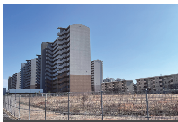
高層化した建替え後の公的住宅では、周辺の団地に配慮し色彩等により分節化（新金岡）
