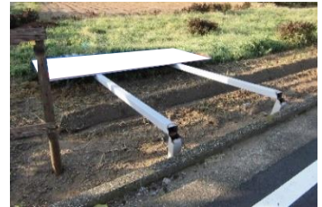
屋外広告物の倒壊
