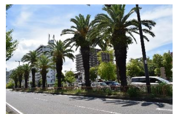
幹線道路の景観（国道26号）
