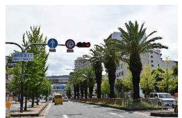
国道 26 号（フェニックス通り）
