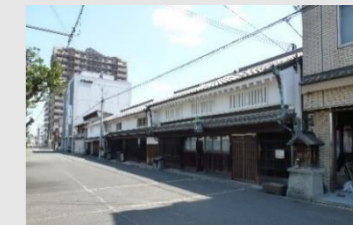
⑪ 古くからの町家が残る大道筋沿いのまちなみ
