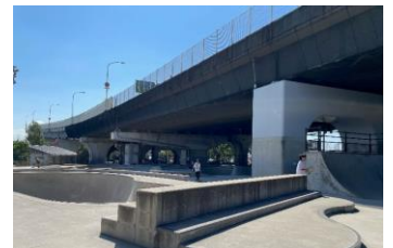
阪和自動車道高架下に整備された原池公園スケートボードパーク
