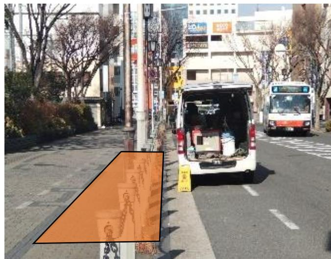
停車帯を拡幅し自動運転車両の走行空間を確保
