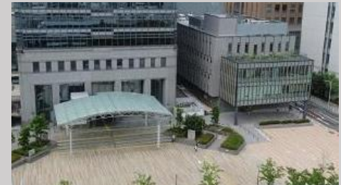
Minaさかい 堺市市民交流広場
