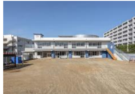
子育て支援施設の導入事例 (府営八尾志紀住宅活用地)
