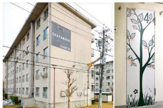
住棟壁面サインの事例 (府公社茶山台団地)
