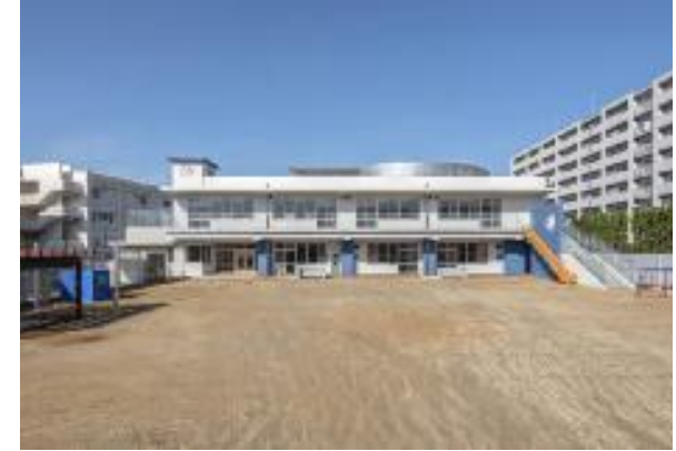
子育て支援施設の導入事例 (府営八尾志紀住宅活用地)
