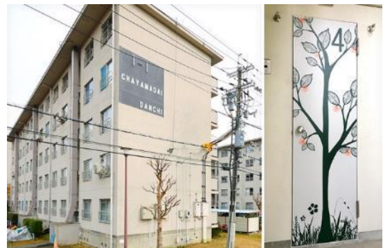
住棟壁面サインの事例 （府公社茶山台団地）
