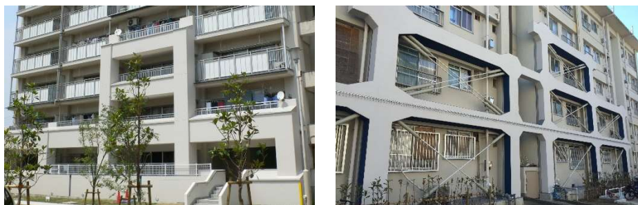
耐震改修工事の事例 (左：府営城山台2丁住宅、右：公社茶山台団地)
