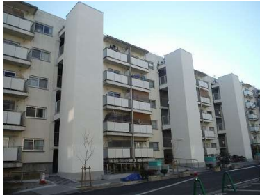
EV 設置工事の事例 (府営高倉台第 3 住宅)
