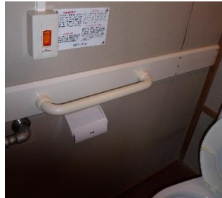
バリアフリー改修の事例 (府営堺戎島住宅)
