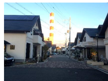
戸建て住宅の導入事例 (府営田ノ口住宅活用)
