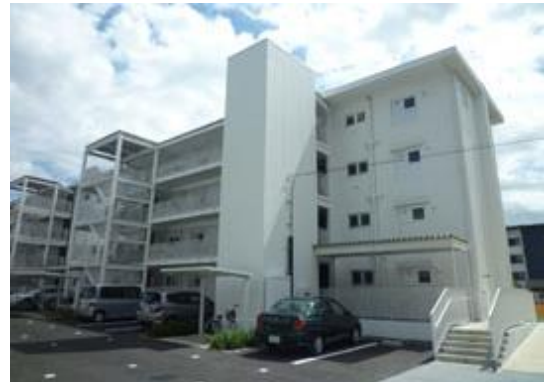
既存の階段室を撤去し、エレベーター・外階段・外廊下を新設
