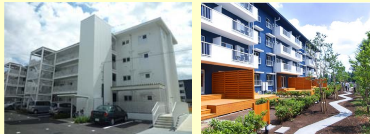
既存中層住棟の改修事例
