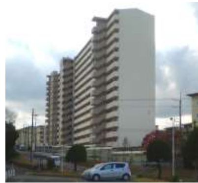
建替事業後の公的賃貸住宅の事例 (府営若松台第2住宅)
