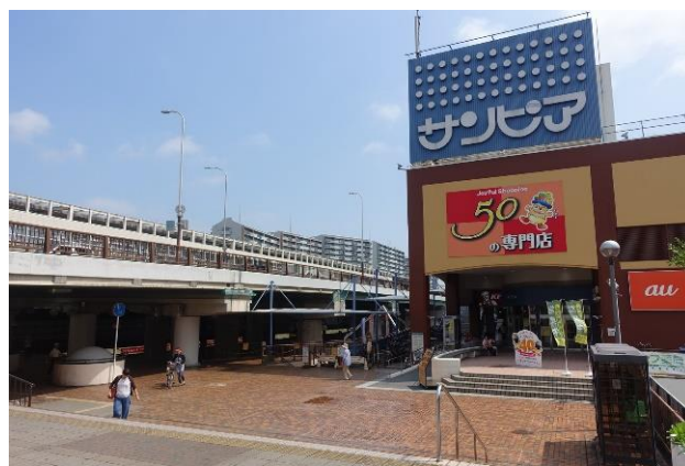
ペDESTリアンデッキ沿いの商業施設
