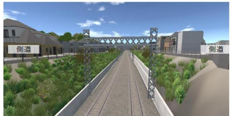
周辺地盤より鉄道が低くなる場所は掘割構造になり、0～約4mの高低差がつきます。現在の榎小学校付近です。
