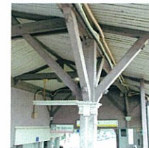
旧ホームの柱架構
