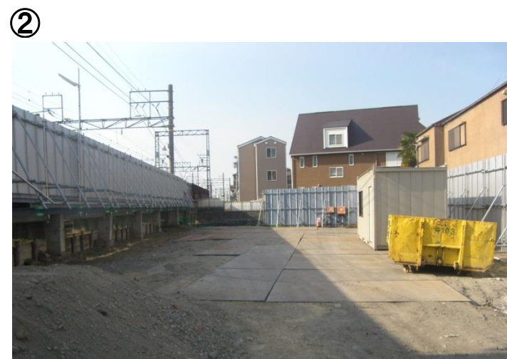
② 上りホームを改修中です。
