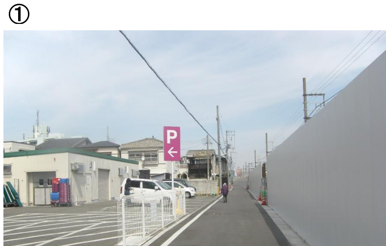
① 工事ヤードを囲む万能塀が設置されました。
