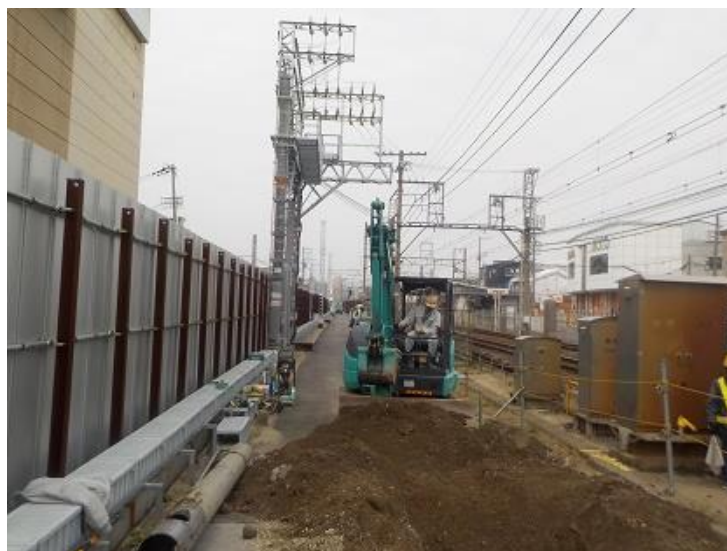
仮上り線の電柱が建てられています。
