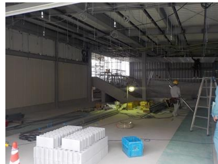
仮駅舎の設備工事を実施しています。
