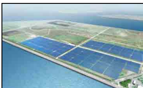
図 堺第 7-3 区太陽光発電施設
