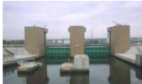
図 海岸保全施設（現況）
