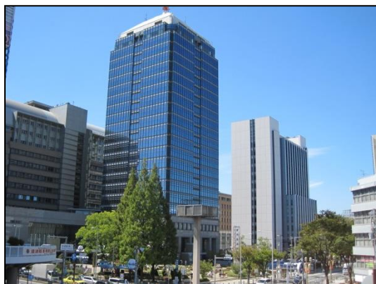
堺市庁舎と堺地方合同庁舎
