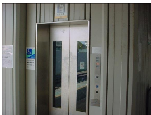
堺東駅バリアフリー化（エレベーター）
