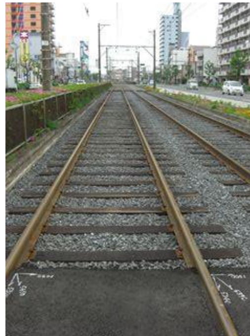
整備された軌道
