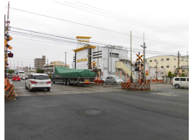
石津北停留場踏切（東湊2-1踏切）
